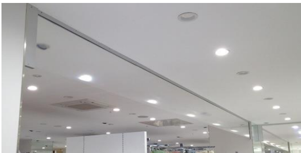
テンションタイプ施工例
