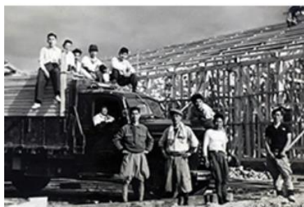
御所実業高校建築現場（1957年）
