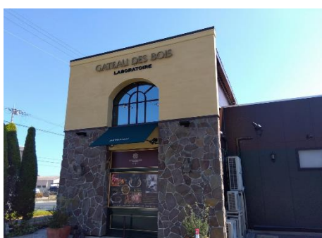
店舗外壁塗装工事
