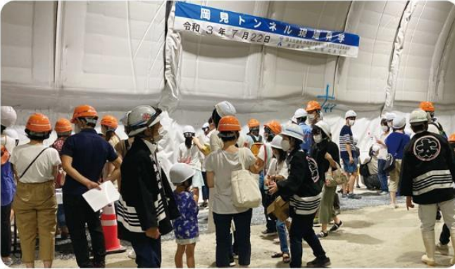
地域住民を対象にした現場見学会（島根県 三隅関門トンネル工事所）
