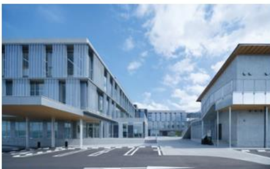
事務所・庁舎: 井手町庁舎【免震】(京都府井手町)
