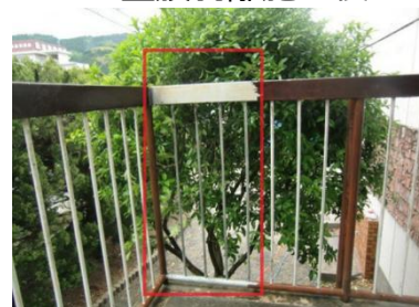
塗膜剥離施工後
