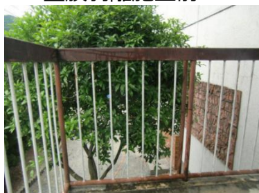
塗膜剥離施工前
