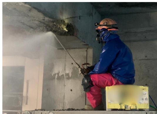
超高压洗浄工事の様子
