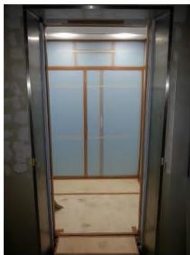
養生工事施工後
