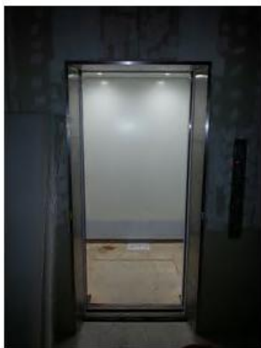
養生工事施工前
