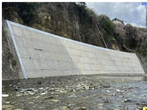
橋本川(御幸辻) 河川 災害復旧工事
