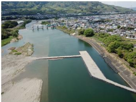
紀ノ川小田地区護岸 補修工事
