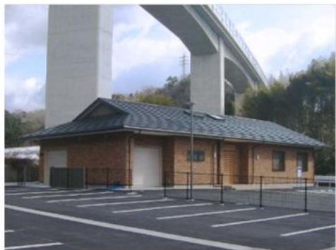
尾崎集会所 新築工事
