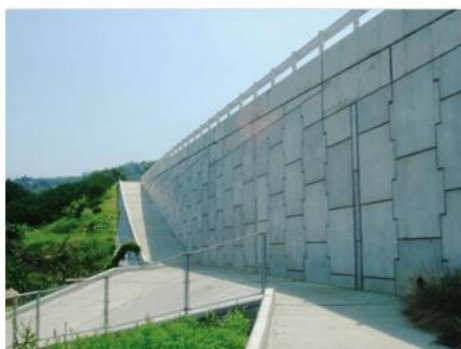
紀の川左岸地区 橋本工区南馬場 道路工事
