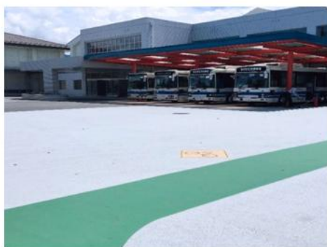
きのかわ支援学校管理棟 大規模改造建築工事
