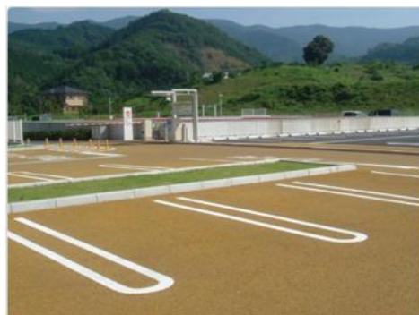
国保橋本市民病院外溝 土木工事
