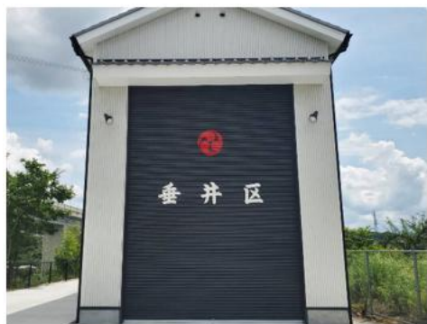
垂井区だんじり小屋 新築工事
