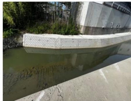
大坪川堤防 改修工事
