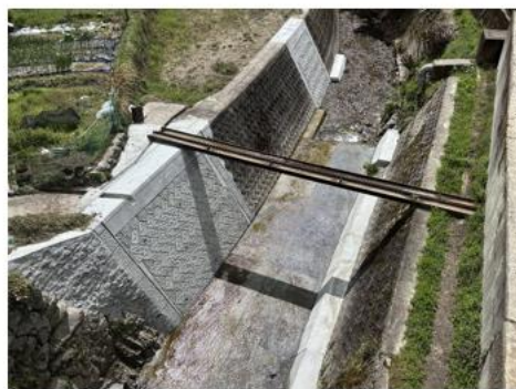
橋本川(矢倉脇) 河川 災害復旧工事
