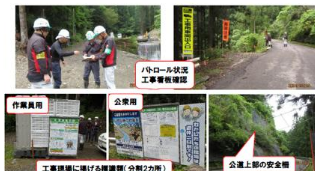
安全パトロールの様子
