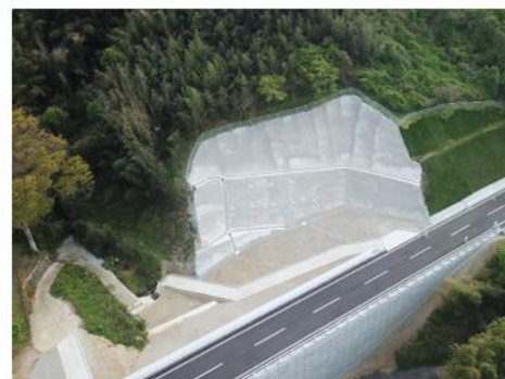
紀の川左岸地区 西洪田 (その17) 工事
